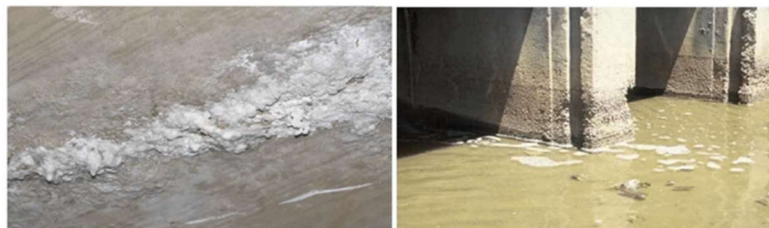
الشكل 1: أمثلة التدهور لبعض العناصر الخرسانية بسبب الكبريتات
